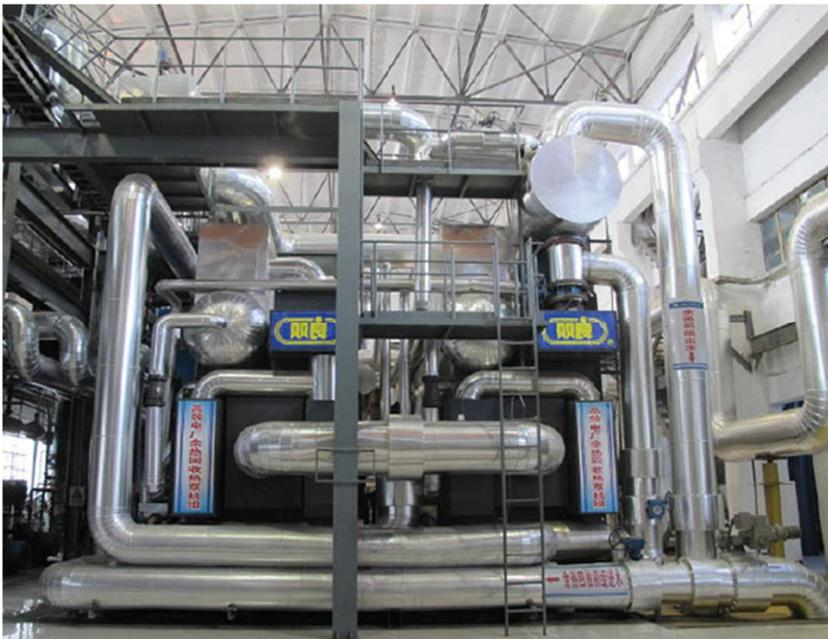
В каждом из четырех тепловых насосов установлен компрессор, который приводится в движения небольшой турбиной, подключенной к новому отбору пара основной турбины с давлением 0,5 МПа. В новый отбор идет 550 т/час пара, при полном расходе пара основной турбины порядка 1650 т/час. В контуре теплового насоса циркулирует бромистый литий. Отбираемый пар с
