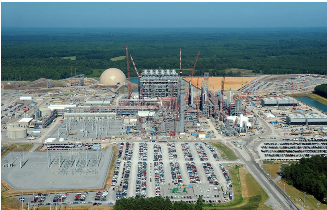
Строительство ТЭС Kemper County, штат Миссисипи, США
