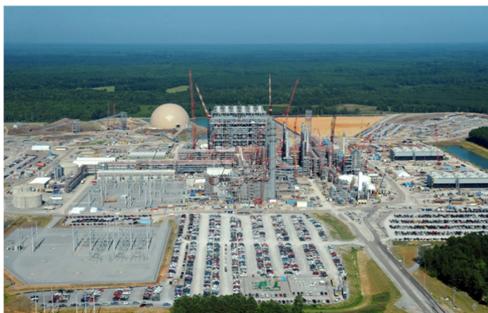
Строительство ТЭС Kemper County, штат Миссисипи, США
