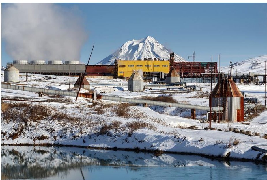
Камчатка, Мутновская геотермальная станция. Фото: Alexander Piragis / Фотодом / Shutterstock
